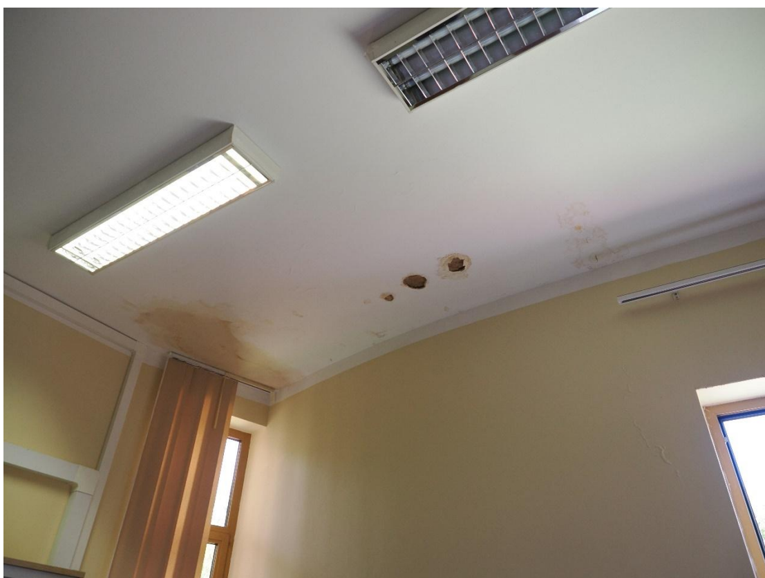
Fot. 2 Ślady przecieków w pomieszczeniu pod dachem płaskim.
