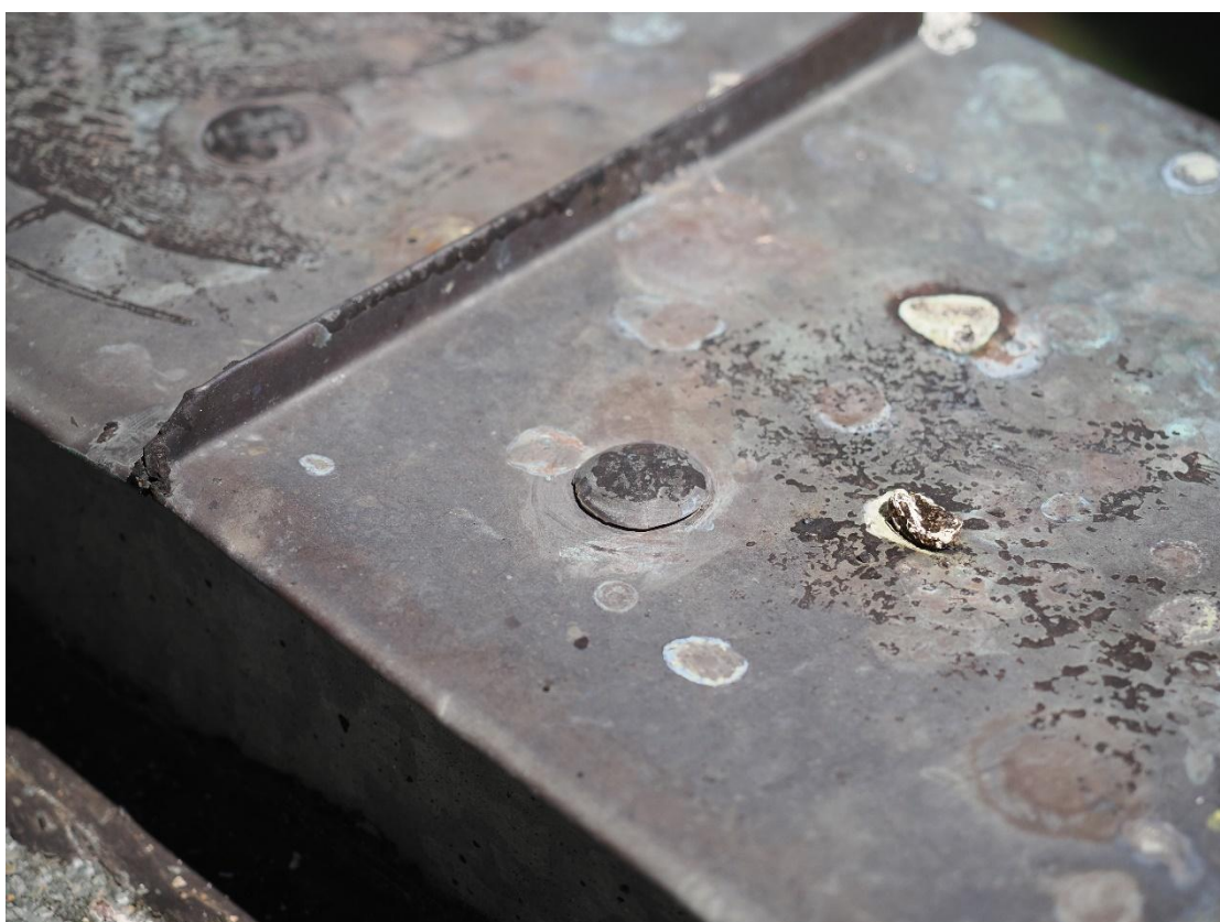
Fot. 8 Kapsel uszczelniający wkręt mocujący obróbkę – brak szczelności.
