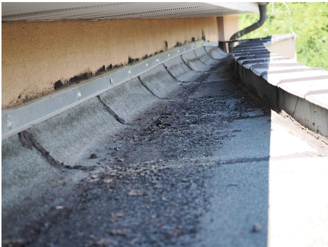
Fot. 3 Zanieczyszczenia dachu utrudniające spływ wody.
