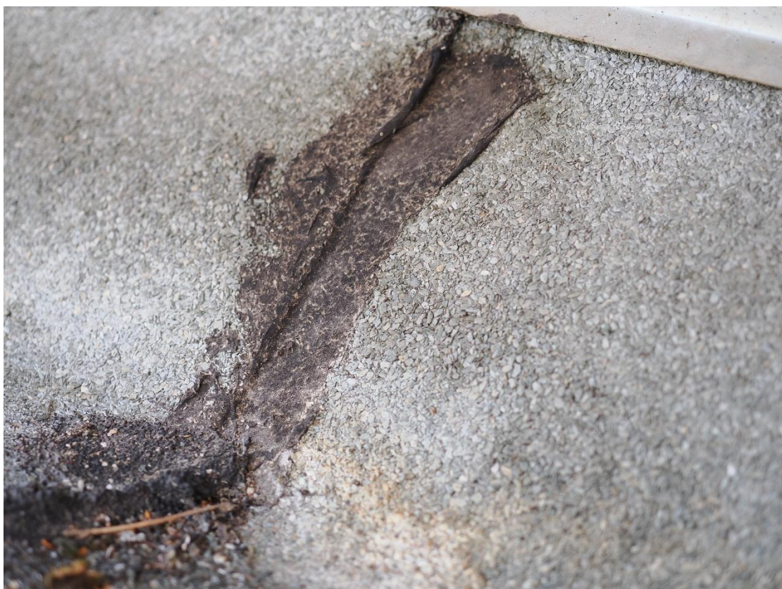
Fot. 4 Połączenie pasm papy – przegrzanie pokrycia, ubytek posypki kwarcowej.
