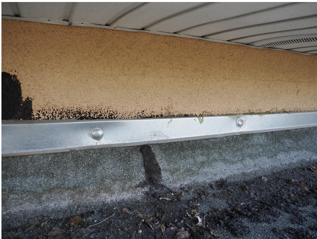
Fot. 5 Obróbka blacharska mocująca papę do ściany budynku.
