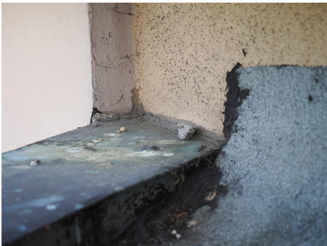
Fot. 6 Pęknięcie na styku obróbki blacharskiej attyki ze ścianą budynku.
