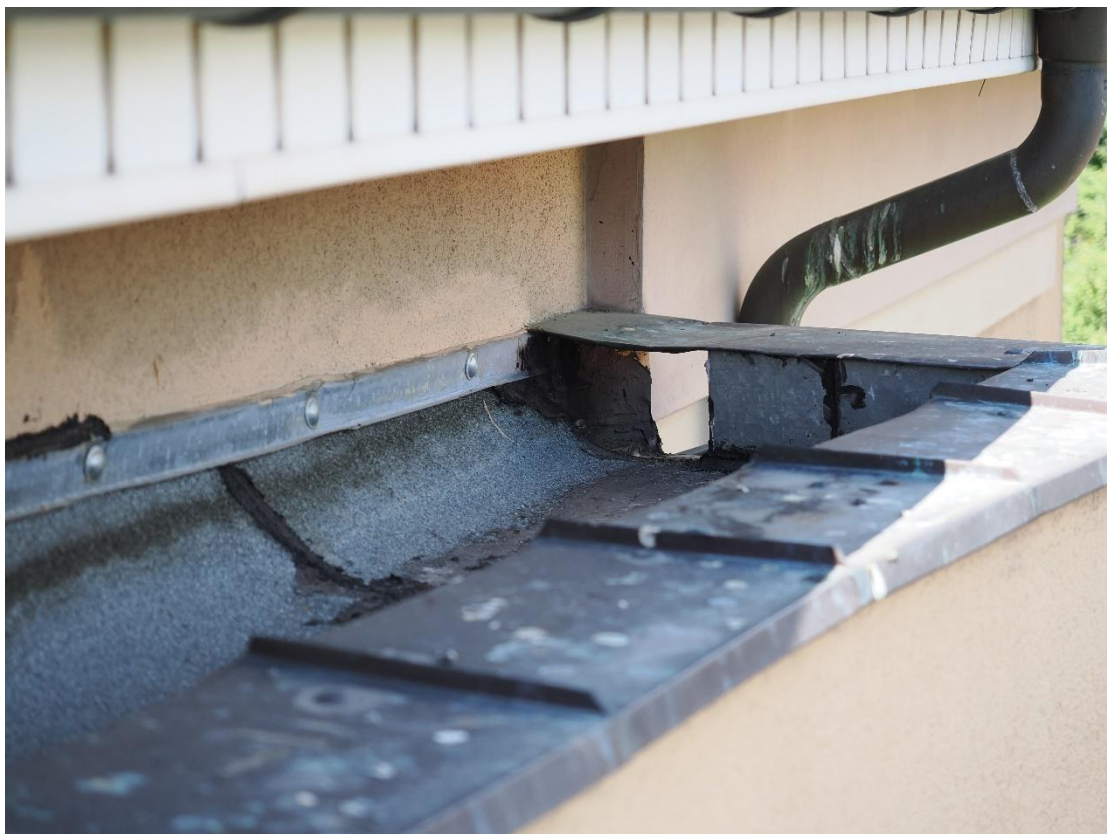
Fot. 9 Zrzut wody do rury spustowej.
